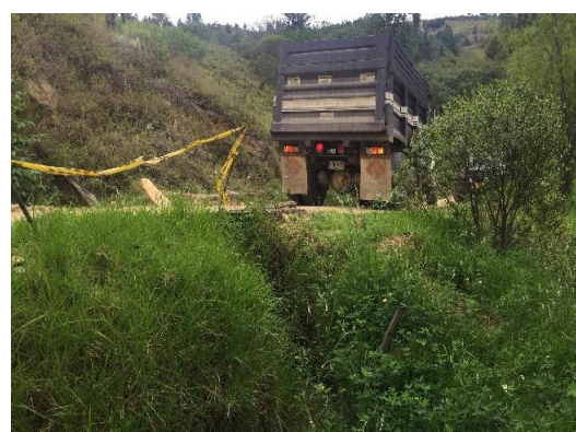
Fotografía 3-26 Paso de canal de riego local con estructura de paso en madera
