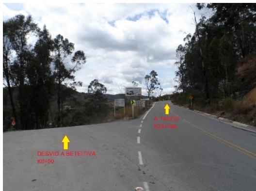
Fotografía 3-15 Inicio Vía 2.1 Abcisa: K0+000 Coordenadas: 1.139.277 E, 1.142.033 N
