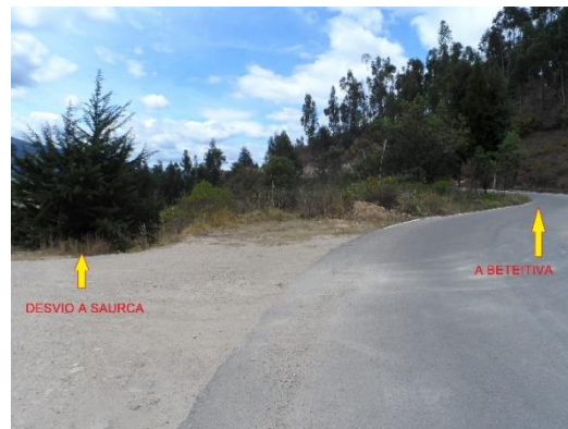
Fotografía 3-16 Fin Vía 2.1 Abcisa: K6+290 Coordenadas: 1.139.623 E, 1.144.473 N
