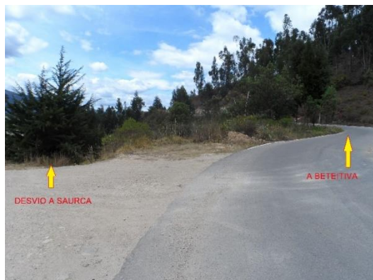
Inicio Vía 2.2 Abscisa: K0+00 Coordenadas: 1.139.621 E, 1.144.476 N
