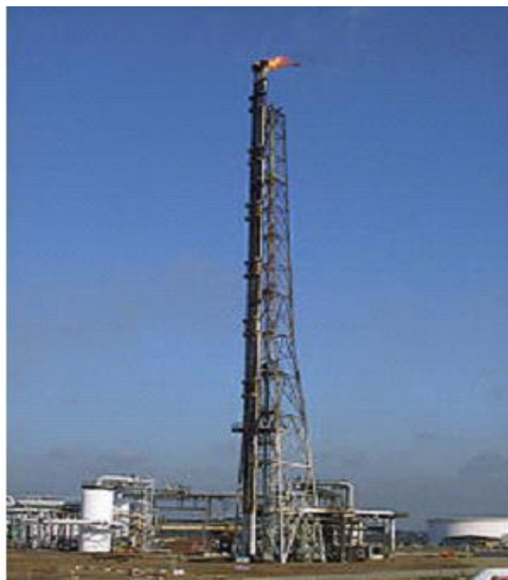
Figura 3-82 Diseño conceptual y ejemplo de una tea en funcionamiento
