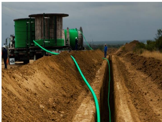
Fotografía 3-28 Carretes de Tubería Flexible
