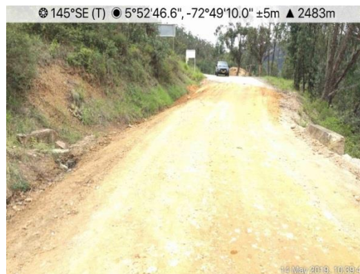
Fotografía 3-18 Vista general del estado actual de la vía terciaria con mantenimiento reciente
