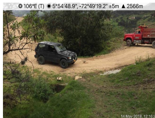
Fotografía 3-22 Punto identificado para revisión de radio de curvatura mínimo para tractocamiones
