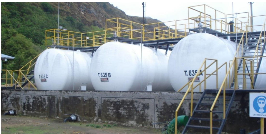
Figura 3-79 Tanques de almacenamiento con dique de contención
