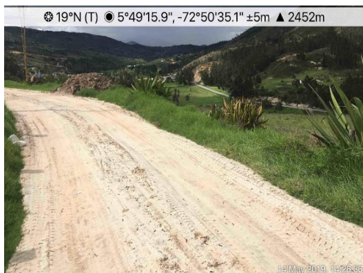
Fotografía 3-11 Vía angosta con capa de rodadura en arena y ancho inferior a 3m
