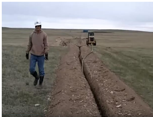
Fotografía 3-29 Zanja para tendido e instalación de Tubería Flexible
