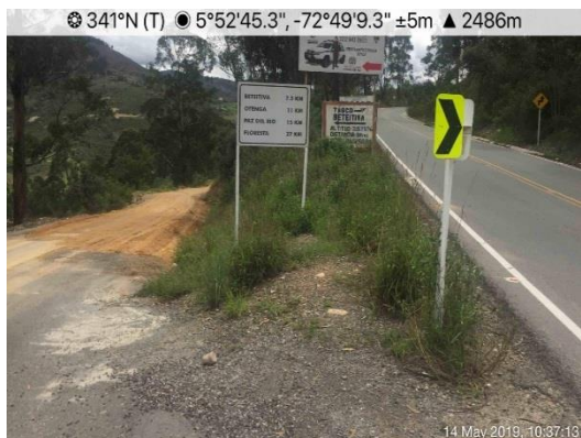
Fotografía 3-17 Punto de inicio de vía terciaria hacia casco urbano de Betétiva
