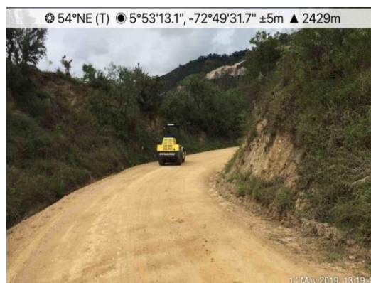
Fotografía 3-20 Obras de mantenimiento a lo largo de este tramo de vía terciaria
