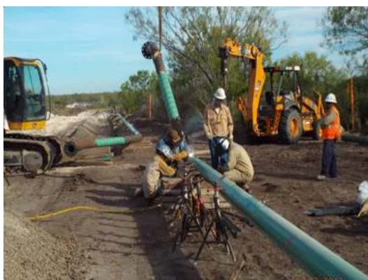
Fotografía 3-30 Empalme de tubería flexible
