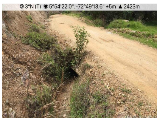
Fotografía 3-25 Paso de canal de riego local con estructura de paso en madera
