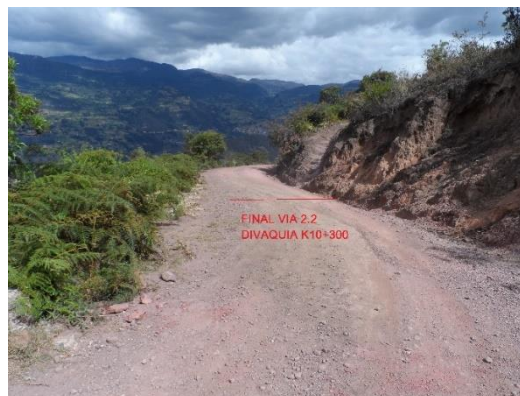
Final Vía 2.2 Abscisa: K9+030 Coordenadas: 1.139.698 E, 1.149.268 N
