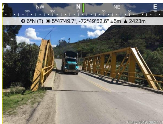
Fotografía 3-5 Infraestructura existente en vía pavimentada Sogamoso - Tasco
