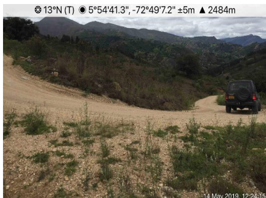
Fotografía 3-23 Punto identificado para revisión de radio de curvatura mínimo para tractocamiones
